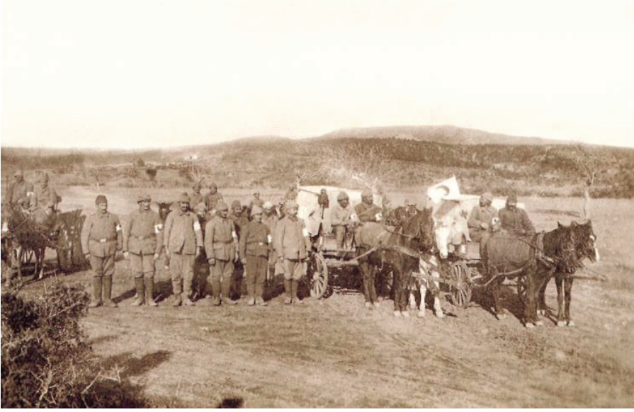
Yaralıları cephedeki araba durak yerinden hastanelere nakleden Sıhhiye Kolu.
